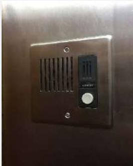
Dispositivo de comunicación instalado al interior de cada ascensor, el cual permite contactarse con conserjería, en caso de sufrir algún incidente como quedar atrapados en su interior.
